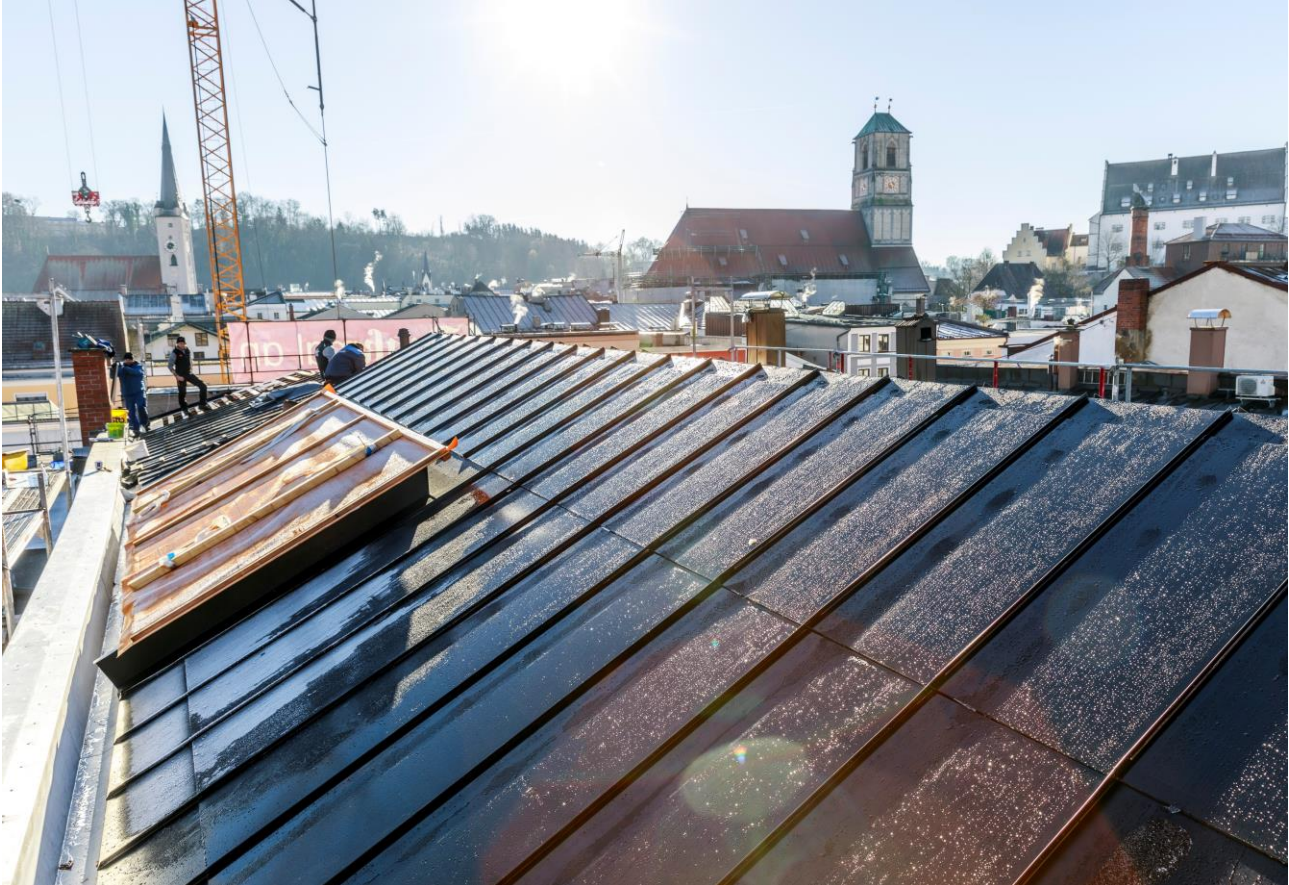
Abbildung 23: Wasserburg am Inn, Ledererzeile, Quelle: BLfD 2024
