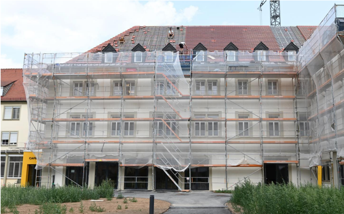
Abbildung 24: Baustelle Kongregation der Schwestern des Erlösers Stadt Würzburg (1), Quelle: G.A.S. planen bauen forschen
