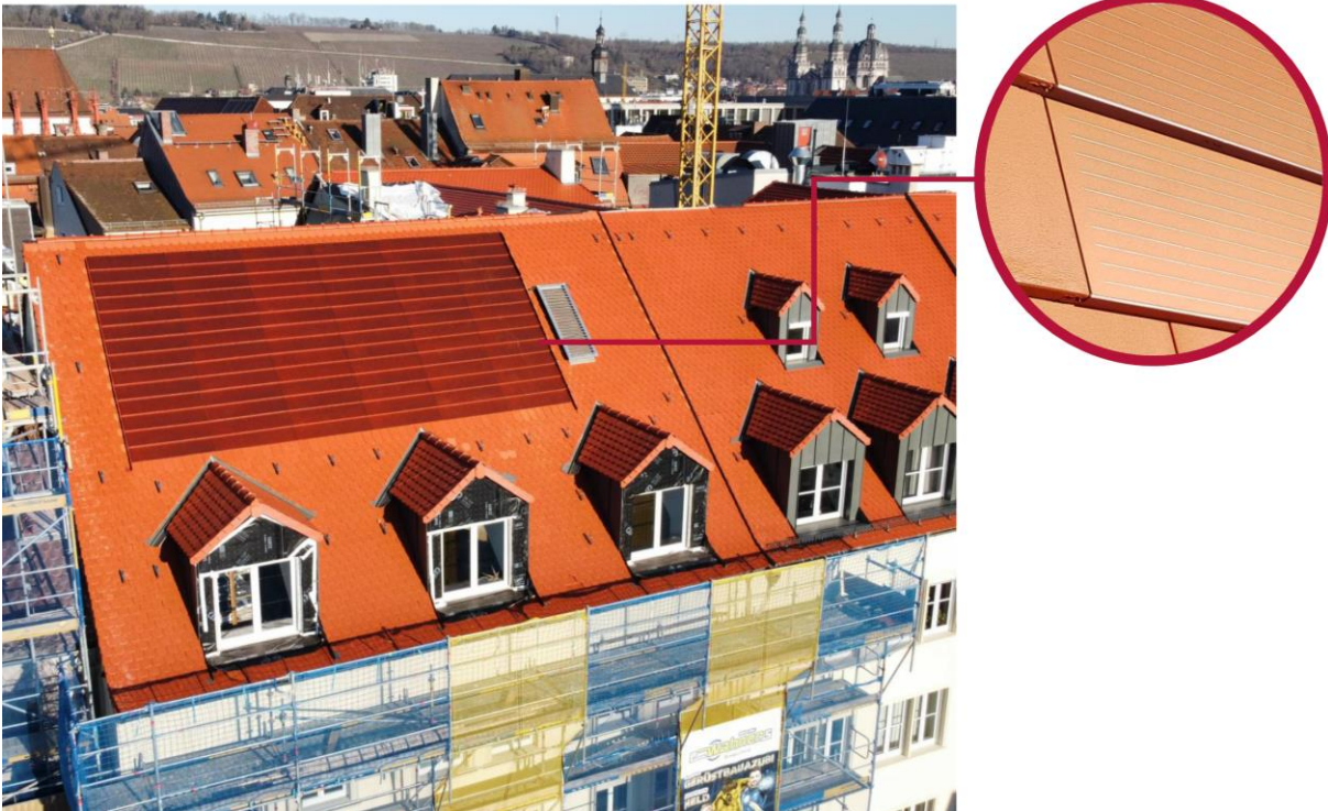
Abbildung 28: Modehaus Schlier mit Planum PV Modulden der Fa. Nelskamp, Quelle Nelskamp
