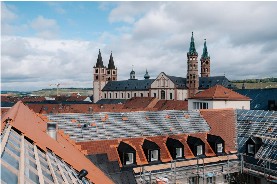
Abbildung 27: Baustelle Kongregation der Schwestern des Erlösers Stadt Würzburg (3), Quelle: Matthias Hofner, matthiahofner-hochzeitsfotografie.pixieset.com
